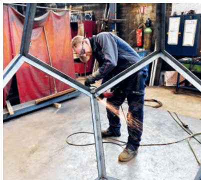
Un ensemble soudé de profils métalliques peut devenir lourd et volumineux pour les manutentions.
