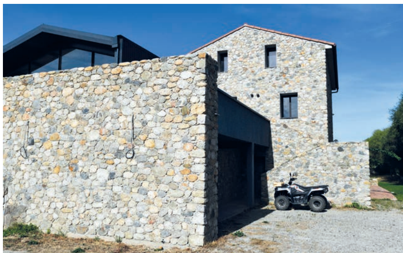
Pierre par pierre, PMG Structures a intégralement reconstruit l'ancienne bâtisse d'un domaine viticole.
