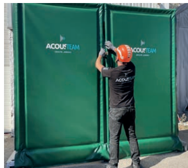
Un technicien installe une bâche acoustique.
